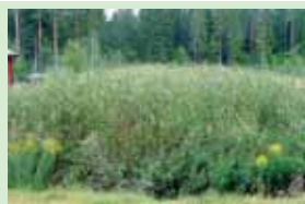
2001 Водоочистная станция Швеция 1.700 m 2 Тростниковый фильтр
